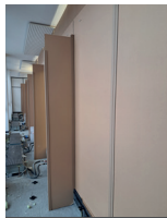
PAROI ANTI-POUSSIÈRE LORS DES TRAVAUX
